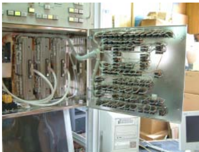
演奏所 操作・表示盤の制御機器
