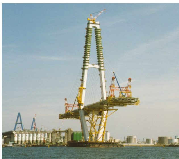
写真3：架橋中の名港中央大橋
